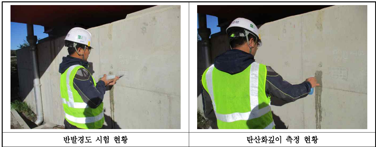
【사진 28.4.1】 콘크리트 내구성조사 현황
