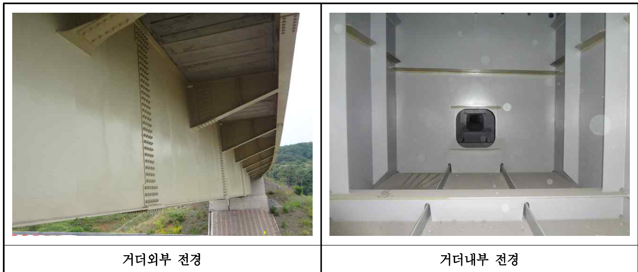
【사진 28.3.4】 거더 전경
