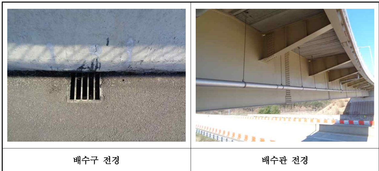
【사진 28.3.19】 배수시설 전경
