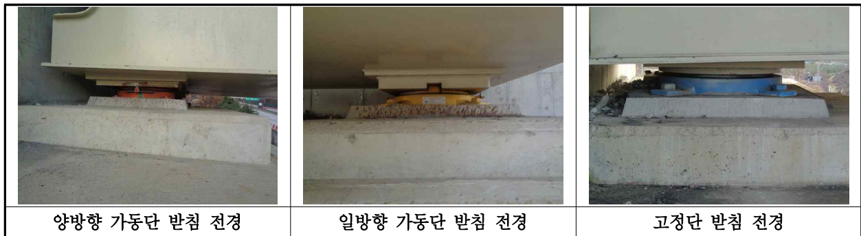
【사진 28.3.10】 교량받침 전경
