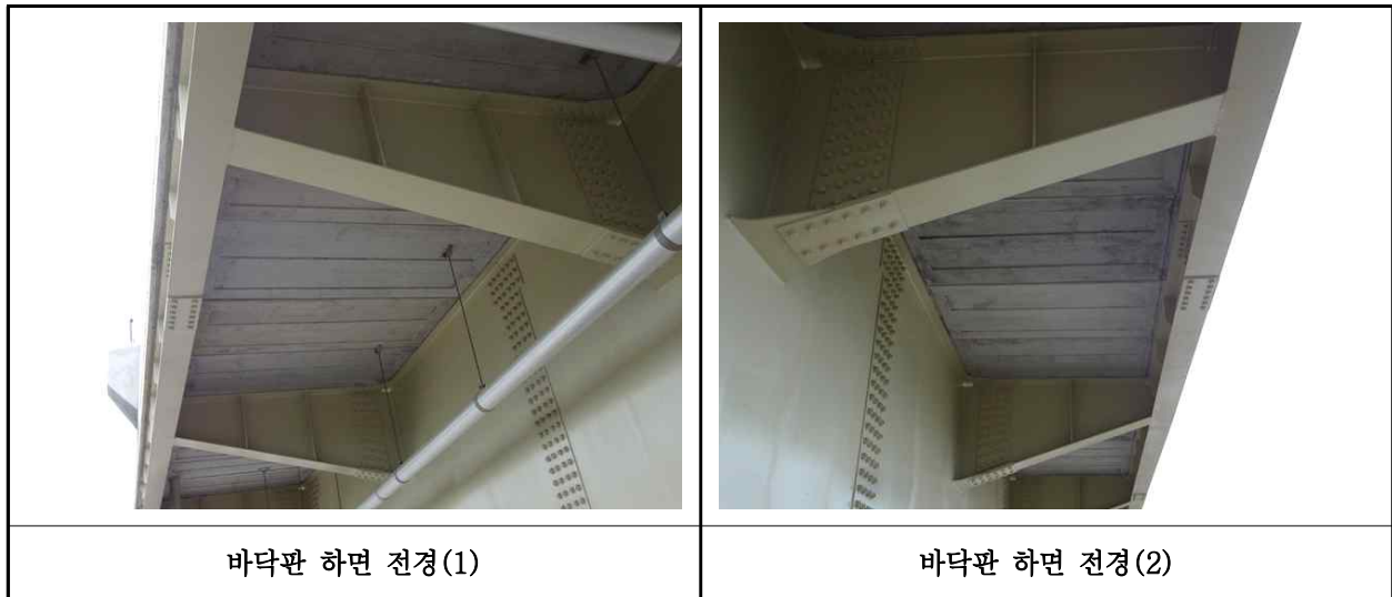
【사진 28.3.2】 바닥판하면 전경
